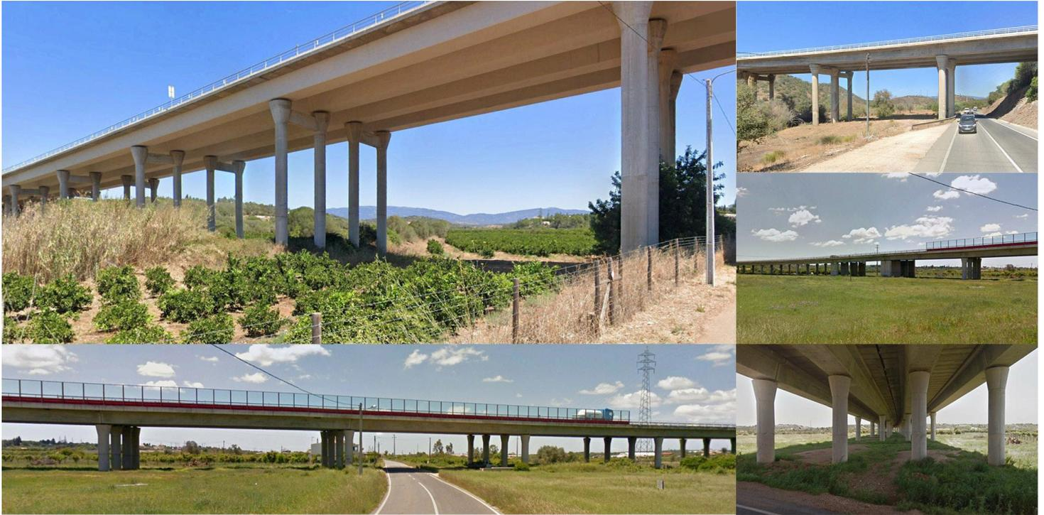
Proyecto de construcción de 11 viaductos, 30 pasos superiores o inferiores y un falso túnel. Los viaductos se resuelven con tableros prefabricados con 2 vigas artesas a las que se da continuidad posterior mediante postesado de barras de alto límite elástico. Los viaductos disponen de amortiguadores en los estribos para disipar las fuerzas sísmicas.
